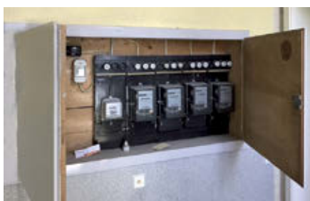
Zähleranlage zu Beginn der Sanierung
