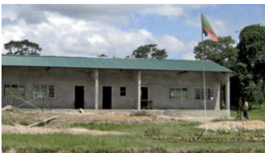
Weiterführende Schule kurz vor der Fertigstellung.
