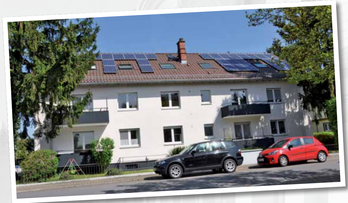
Dachsanierung und Installation einer Fotovoltaik-Anlage in der Brahmstraße 4 in Eppelheim sowie Erneuerung der Fassade
