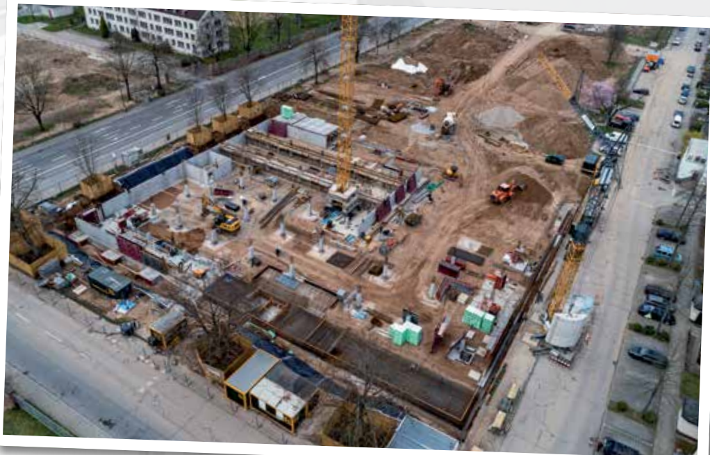
Bautenstand Keller für Nahversorgungszentrum und Pflegeheim sowie weitere Gewerberäume auf Baufeld A4
