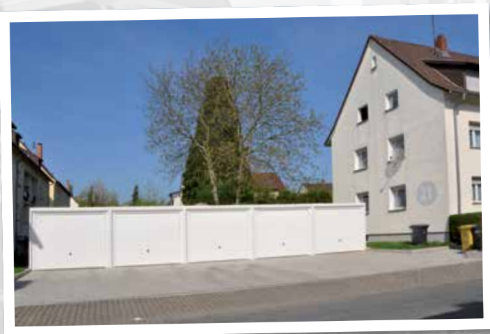
Neubau von 5 Garagen im Langgarten 21 in 69124 Heidelberg-Kirchheim
